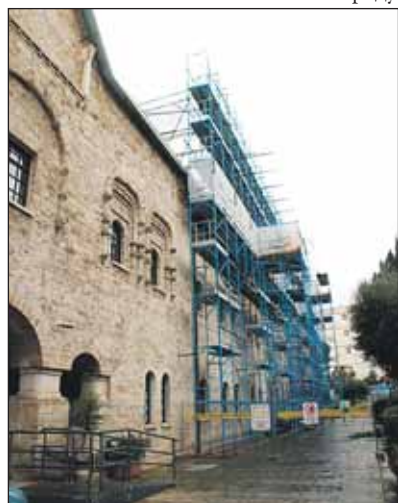
Русское подворье в строительных лесах
