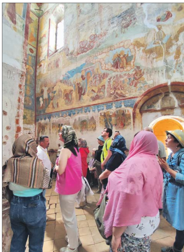
А внутри бесценные фрески разрушаются...
